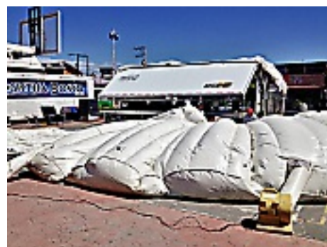
> Ya que está armado y nivelado el escenario, cuatro motores inflan la concha.
